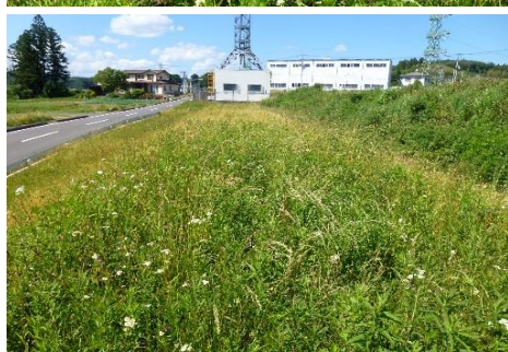
展望地（道路脇の盛土）の状況
