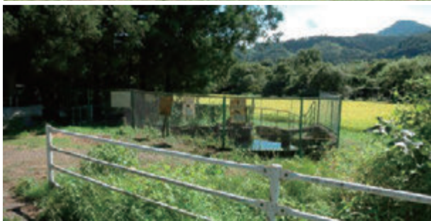
分水工の全景
