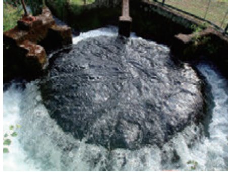
疣岩分水工 (水力発電に利用した水をサイフォンで対岸に導水し分配)
