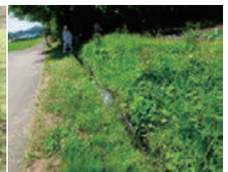
疣岩分水工から引かれた 黒沢尻用水が田畑を潤す
